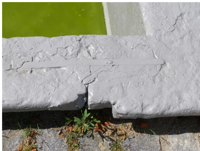
Detaily spojů kamenných prvků a povrchová úprava kamenných prvků
